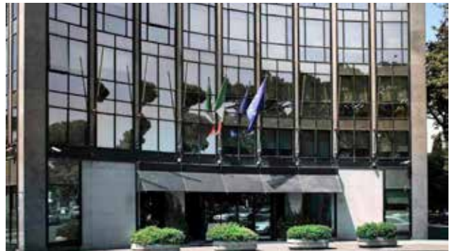
Sede Finmeccanica (Roma – Italia) Equipos: enfriadora RGA
