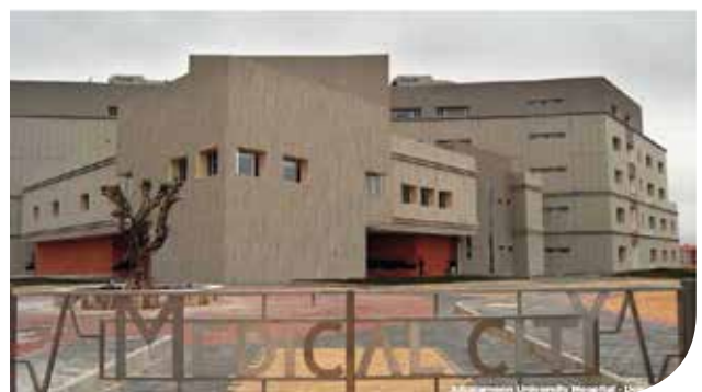
Alkacamoon University Hospital (Deir Atiah – Siria) Equipos: enfriadora RLA, UTAS
