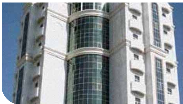
Turkmenistan Projeleri (Turkmenistan – Turquía) Equipos: enfriadoras RHV, RLA, RHA, RGA, fancoils
