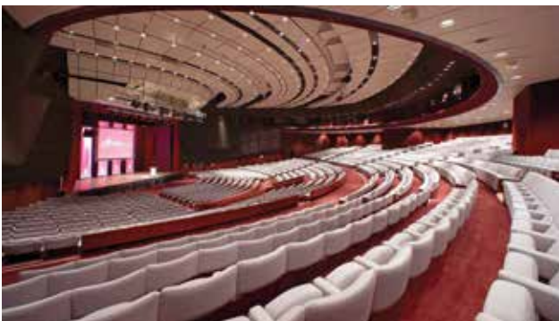
Teatro Real (Londres – Gran Bretaña) Equipos: enfriadora RGA
